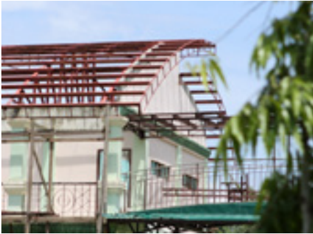
Rohbauphase des Holy Infant College Tacloban.
